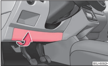
Abb. 157 Untere Seite der Schalttafel: Sicherungsdeckel
