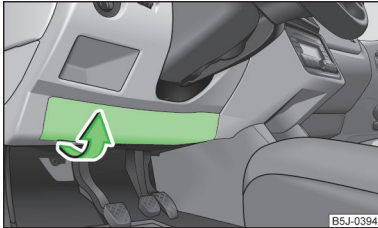
Abb. 150 Unterseite der Schalttafel: Abdeckung des Sicherungskastens
