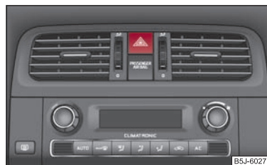
Abb. 38 Schalttafel: Schalter für Warnblinkanlage
