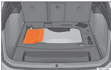
Abb. 231 Einbauort der Batterie im Kofferraum
